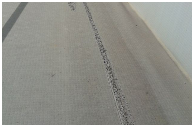
obr. /31/ Nečisté provedení spoje povlakové hydroizolace – pravděpodobně špatná technologie
