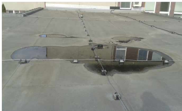
obr. /26/ V místě střešní vpusti vznikají kaluže
