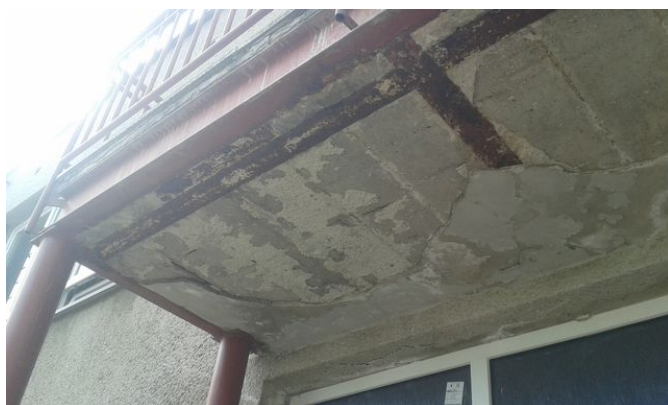
obr. /10/ Ocelové nosníky nejsou chráněny ochrannou vrstvou a dochází k jejich degradaci
