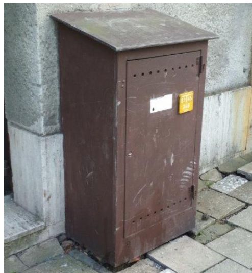
obr. /49/ Hlavní uzávěr plynu je v plechové skříni na vnějším líci fasády
