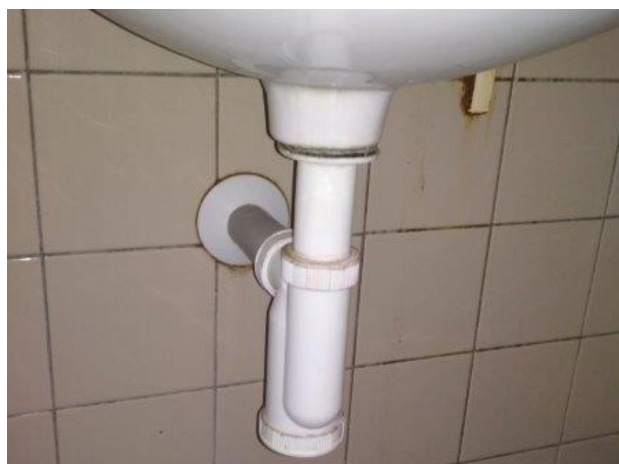
obr. /41/ Původní zápachová uzavírka
