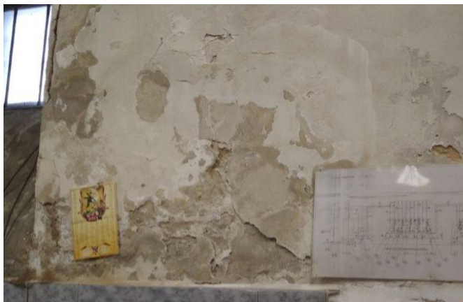
obr. /4/ Vlhkostní mapy, zvýšená vlhkost zdiva a opadávání omítek v suterénu objektu
