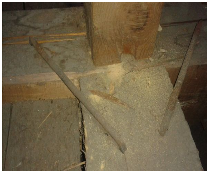
obr. /7/ Na konstrukci krovu se nacházejí drobné stopy po dřevokazných škůdcích
