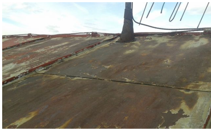
obr. /34/ Ochranný nátěr původní plechové krytiny je značně zdegradovaný
