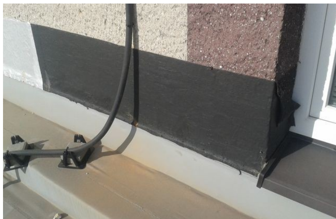
obr. /32/ Hydroizolace z asfaltových pásů ve styku s PVC fólií – PVC fólie a asfaltové pásy mají být od sebe separovány
