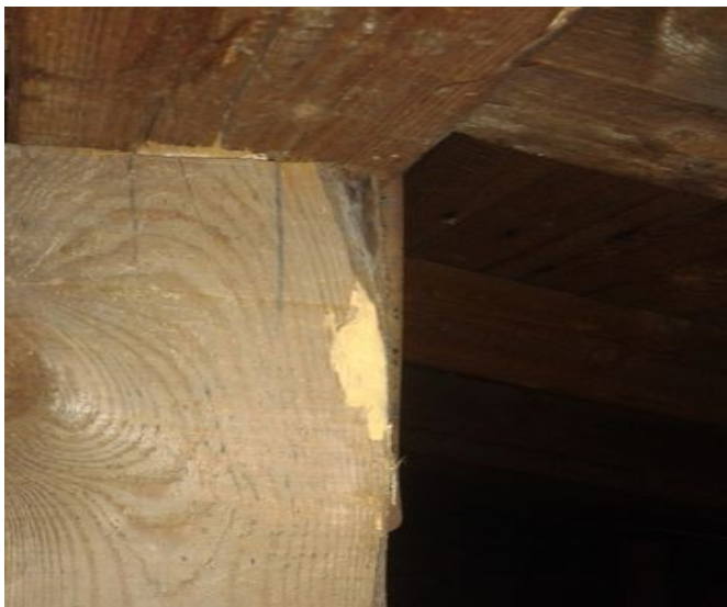
obr. /6/ Na konstrukci krovu se nacházejí drobné stopy po dřevokazných škůdcích
