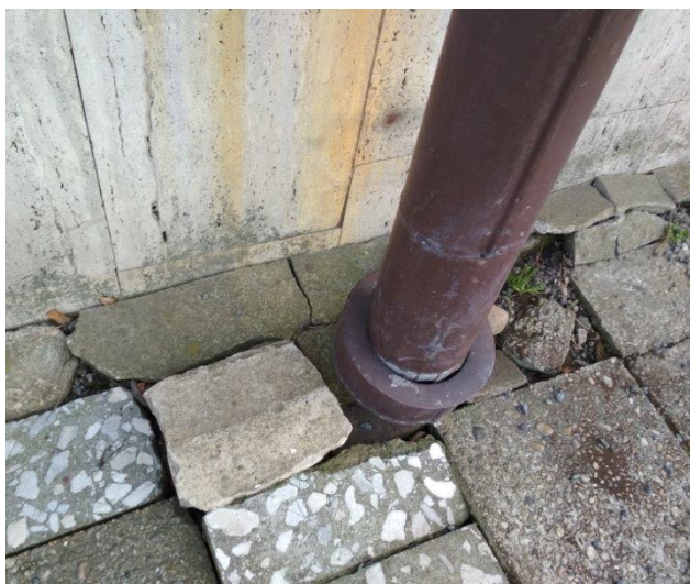
obr. /48/ V místě napojení dešťového svodu do kanalizace chybí lapač střešních splavenin
