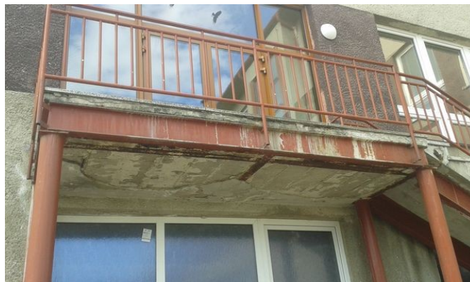
obr. /9/ Stopy zatékání na konstrukci vnějšího schodiště na východní straně objektu jídelny
