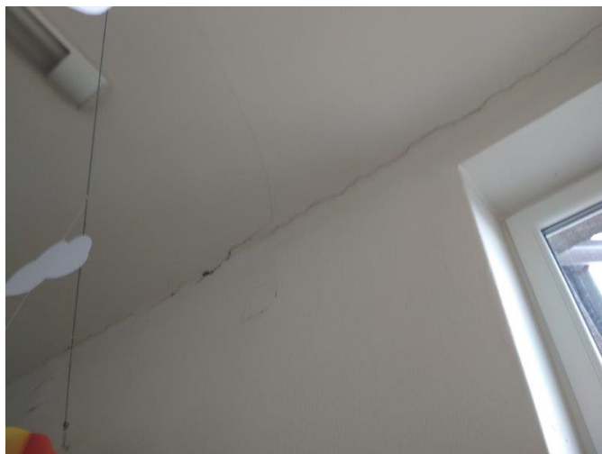
obr. /12/ Vodorovná trhlina v místě uložení stropní konstrukci na svislou konstrukci
