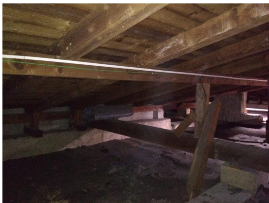
obr. /33/ Šikmá střecha východní části objektu je vynášena pomocí dřevěného krovu
