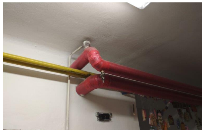
obr. /39/ Ochranný nátěr plynového potrubí je místy zdegradovaný a doporučujeme jeho obnovu
