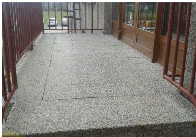
obr. /20/ Cca polovina teracových dlaždic předložené podesty je uvolněná od podkladu
