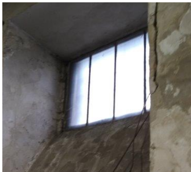
obr. /15/ Sklepní okno je silně zdegradováno a v jeho okolí jsou stopy zatékání
