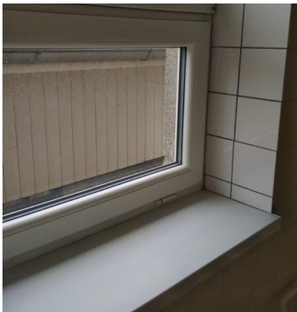
obr. /16/ Ze strany interiéru jsou okenní výplně doplněny plastovým parapetem
