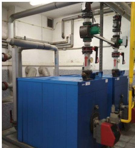
obr. /47/ Zdroj vytápění se nachází v suterénu východní části objektu
