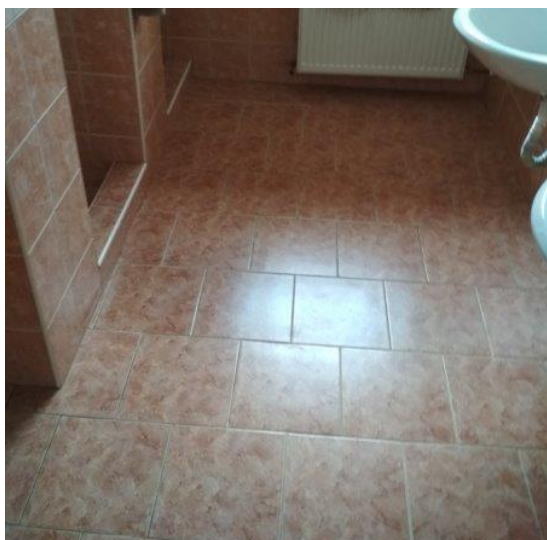
obr. /18/ Před sprchovými kouty se nenachází odpadní kanálek, který by umožnil odtok odstřikující vody ze sprchových koutů
