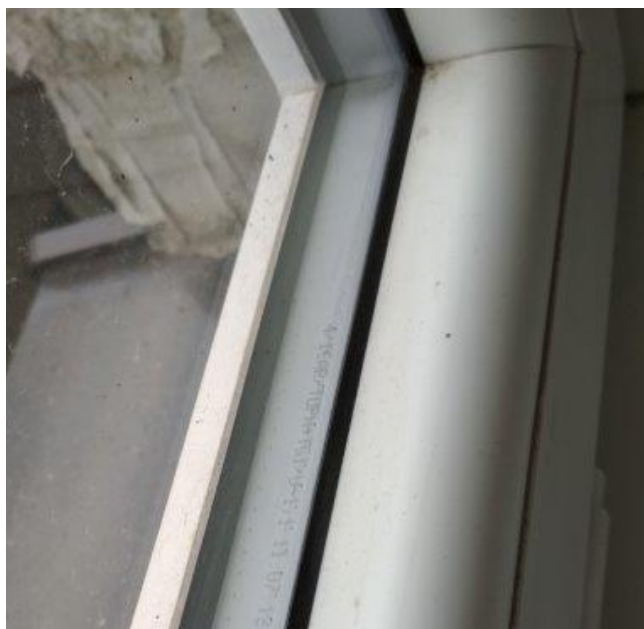
obr. /17/ Plastové okenní výplně jsou zaskleny pomocí izolačních dvojskel s plastovým distančním rámečkem
