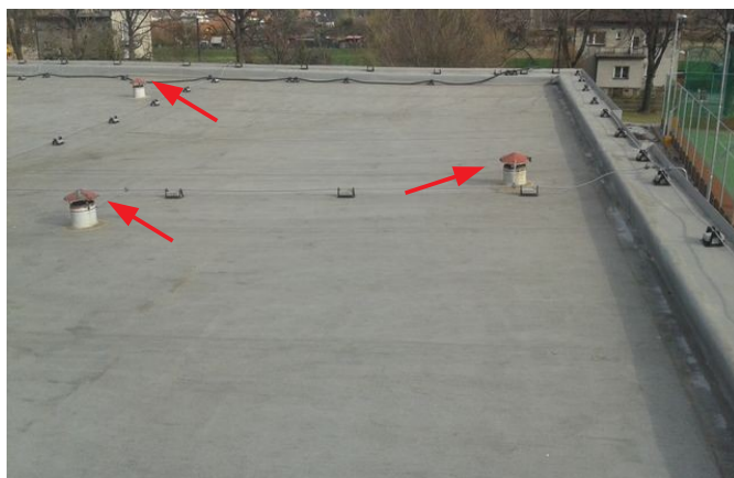
obr. /27/ Pohled na jižní část střechy nad jídelnou – degradace stříšek nad prostupy
