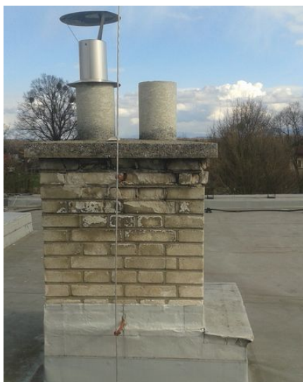
obr. /22/ Komínové těleso nad jižní částí objektu je vyzděno z vápenopískových cihel
