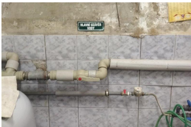
obr. /38/ V místě hlavního uzávěru vody je vodovod veden v plastových trubkách
