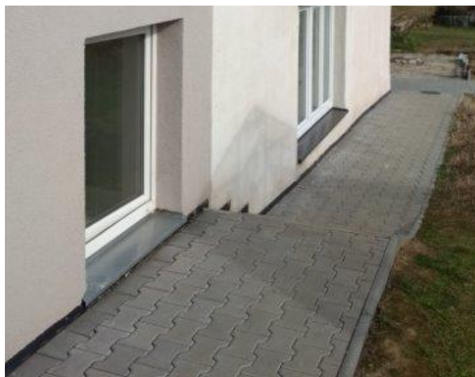
obr. /21/ Okapový chodníček je převážně tvořen betonovou zámkovou dlažbou
