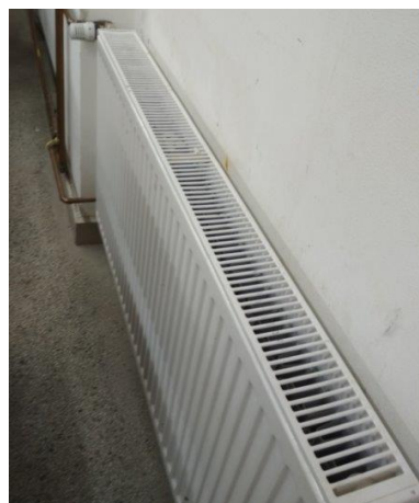
obr. /45/ Vyměněný zdvojený deskový ocelový radiátor
