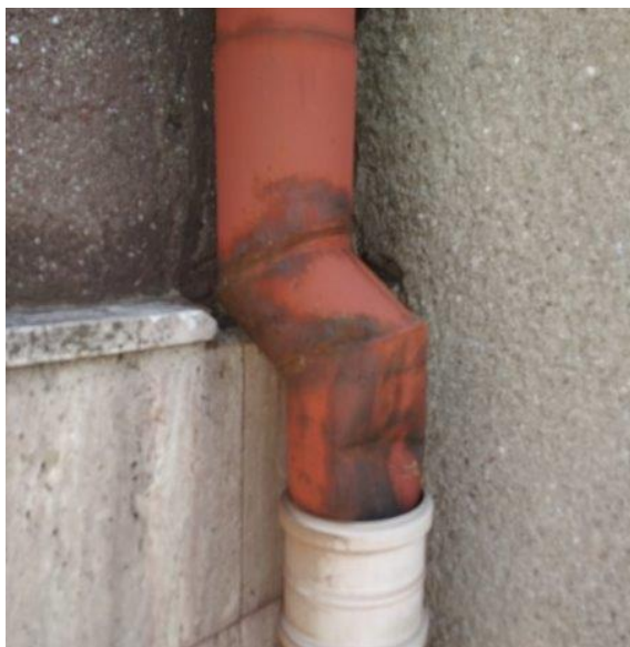
obr. /36/ Střešní svod je zdegradovaný a místy mechanicky poškozený
