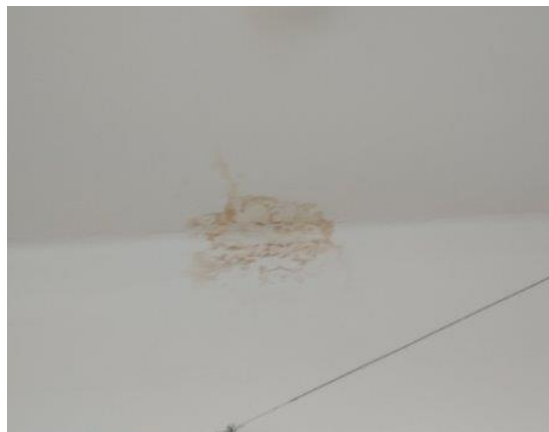
obr. /5/ V třetím nadzemním podlaží se nacházejí stopy po zatékání
