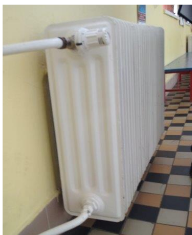
obr. /44/ Původní ocelový článkový radiátor
