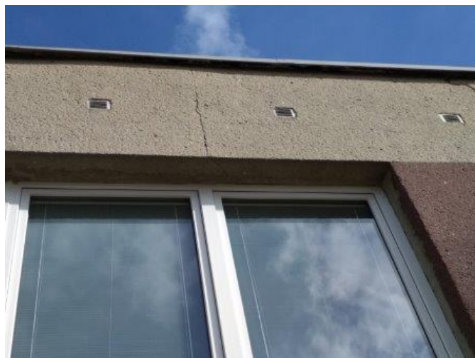
obr. /13/ Svislá trhlina v místě okenního nadpraží
