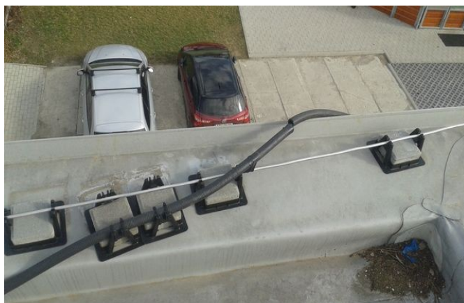
obr. /28/ Pohyb stabilizačních prvků bleskosvodné soustavy, degradace chráničky kabelu
