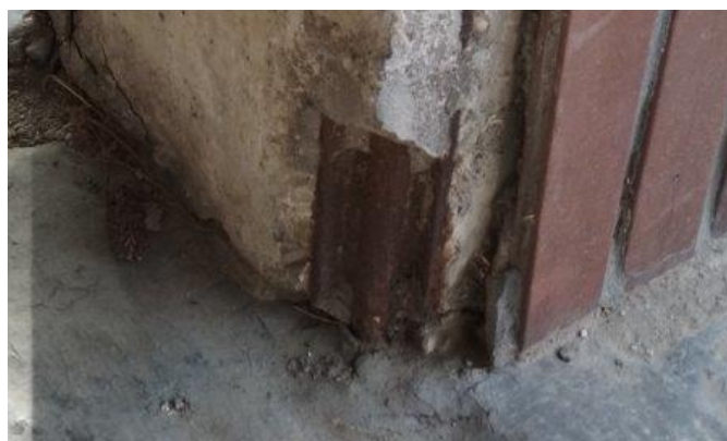
obr. /11/ V místě paty sloupu na severozápadní straně jídelny není nosná výztuž chráněna před vlhkostí a povětrností
